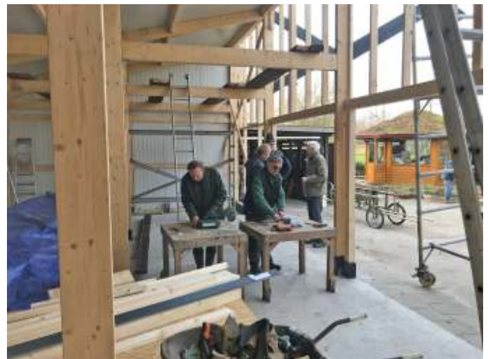
De nieuwbouw van de werkschuur. © Ad Somers
