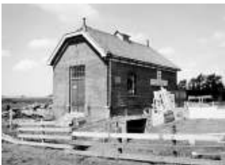
Pompgemaal dat stond aan de Rotte waar nu de Rottebanbrug is.
