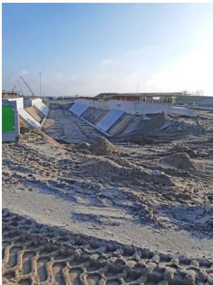
Het nieuwe tunneltje in aanleg. © Jaap van Lien
