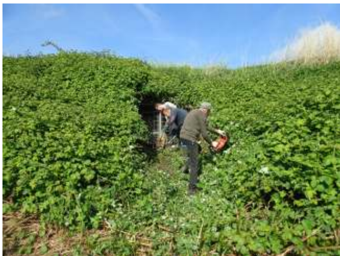
De vleermuizentunnel in het Hoge Bergse Bos was overwoekerd door bramen. © Klaas Verschoor
