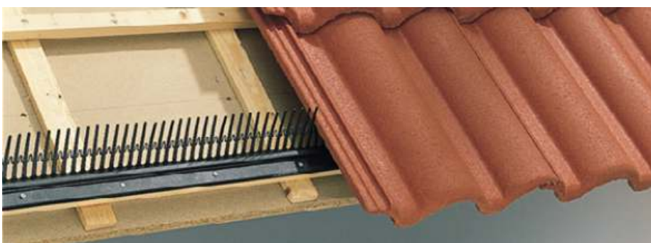
Vogelschroot bij de onderste rij dakpannen. Nestmogelijkheden worden op die manier afgesloten voor huismussen.
