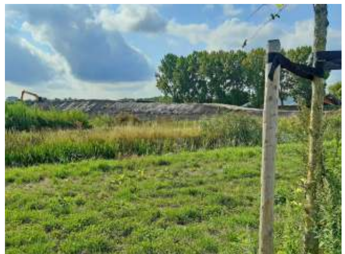
Het zandlichaam voor de fietsoprit naar het recreaduct op de nieuwe A16 is gestort. © Jaap van Lien
