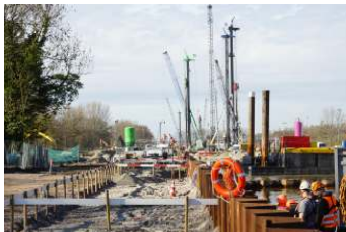
De aanleg van de nieuwe A16 Rotterdam door het Lage Bergse Bos. Het beeld in het anders zo groene bos wordt bepaald door een woud van 'invasieve exoten'! © AHNADIJ
