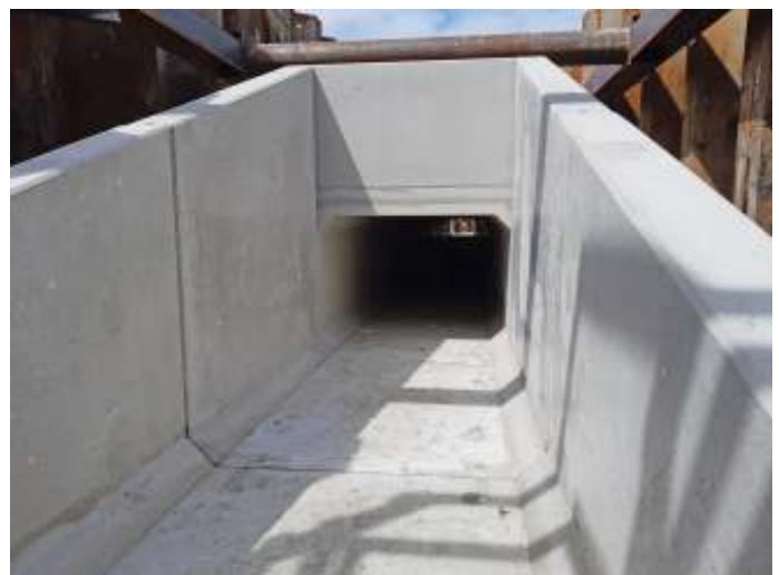
De eco-tunnel in aanleg: de nu nog grijze groene corridor onder de Bergweg Zuid door. © Jaap van Lien
