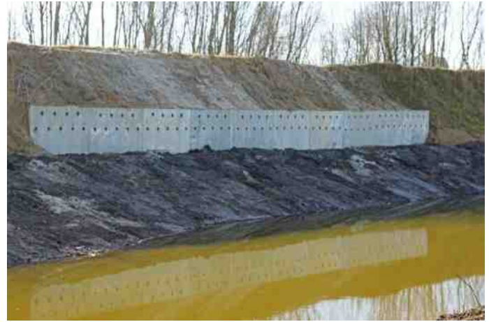
Overwaluwwand in het zanddepot achter de Wiebertjes. © Cor van de Lustgraaf
