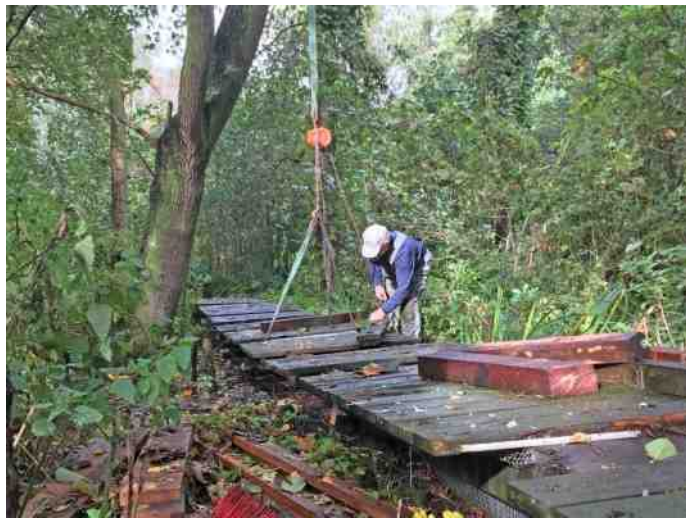
een deel van 12 meter wordt in z'n geheel opgetakeld
