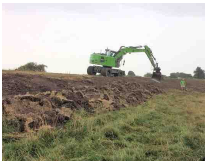
De in de Rottedijk bij de oorsprong in Moerkapelle ontdekte scheur wordt verstevigd met extra grond. © Henk Starink
