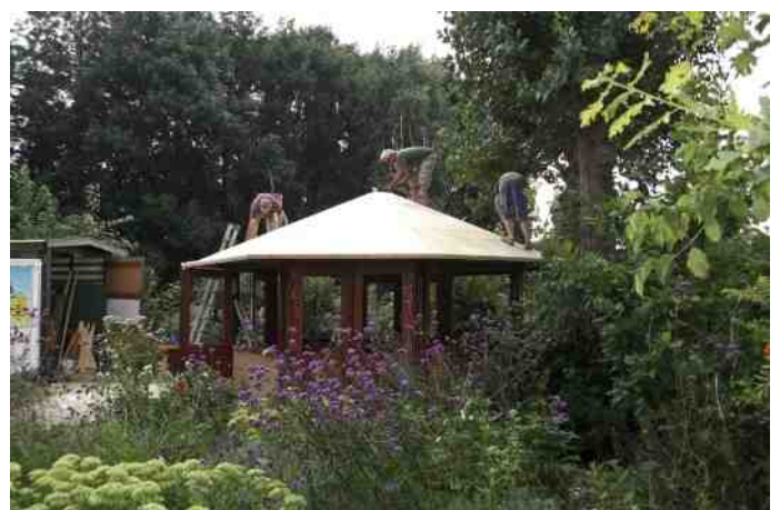
Foto 13-15: dakplaten en isolatie
