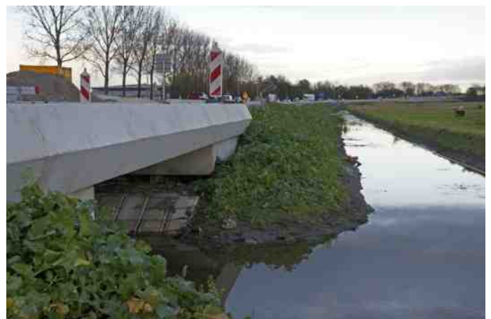
Faunapassage in aanleg onder de N209 tussen Park de Polder en het Triangelpark. © Machiel Brinkhorst
